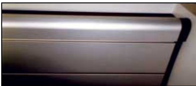
Bilde : Avslutning på kjøletak i OSL bygget på Gardermoen.
