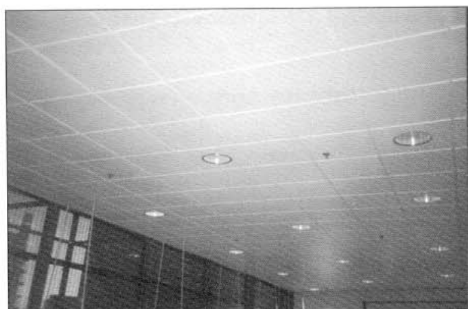
Kontorlandskap med kjøletak MKT-T-F-600-B.
