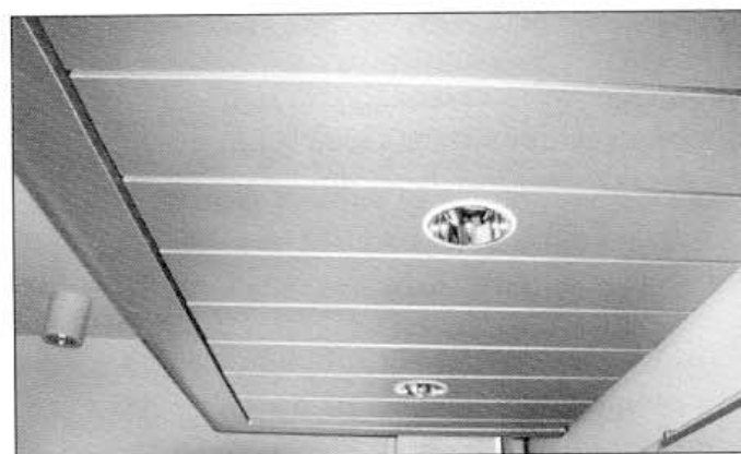
Løsning MKT-T-300 B med integrert rørregister og downlights
