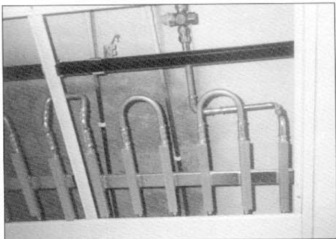
Rørregister ferdig tilkoblet hovedstrek
