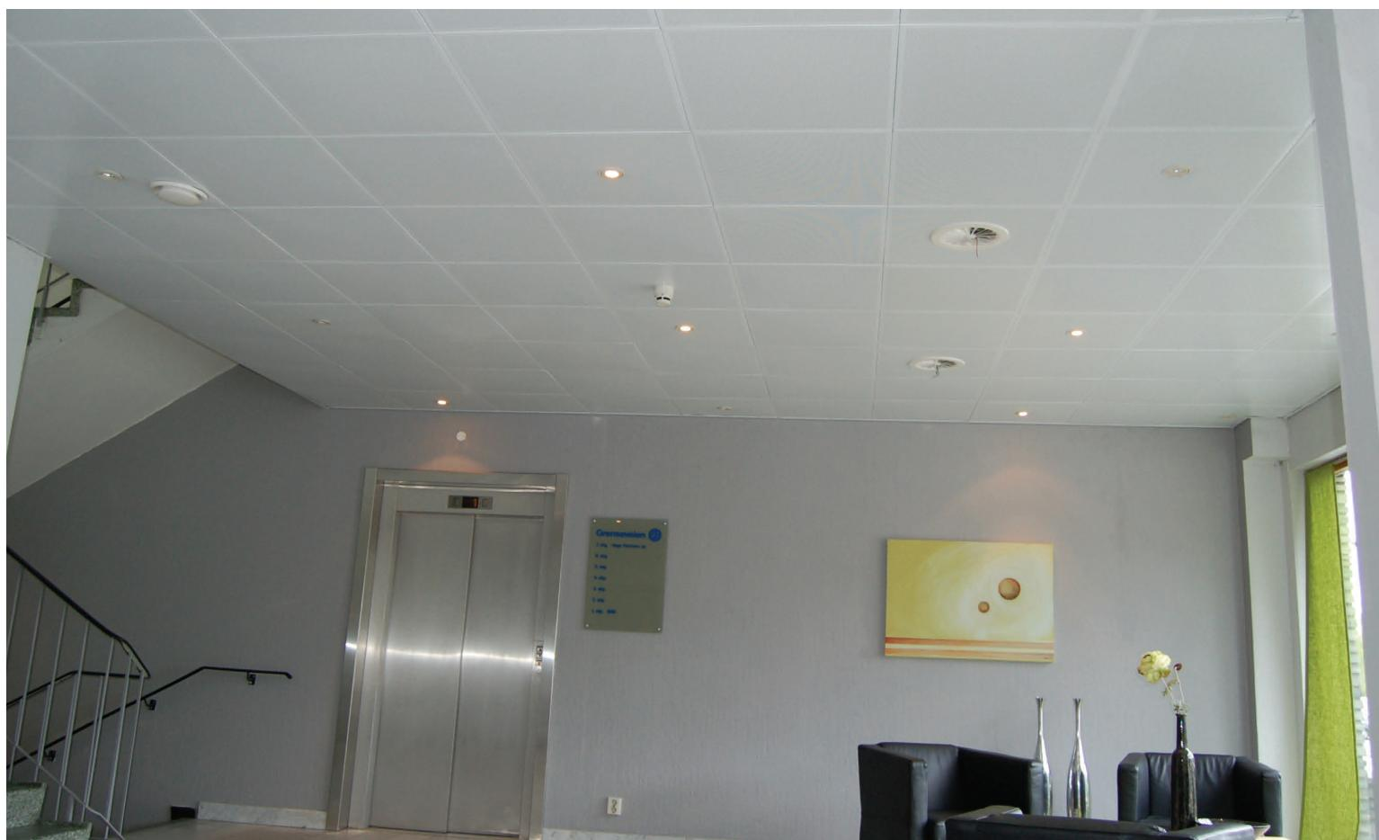
Bilde av Meta klemkassetter i farge standard hvit, perforert, med innfelt belysning, ventilasjon og sensorer.
