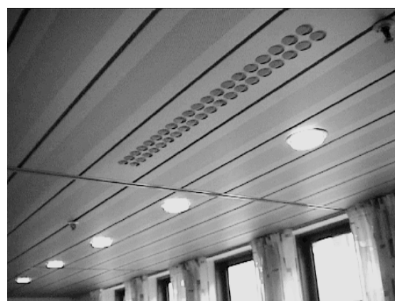
Bilde 1. Viser nytt kjøletak i BNbank, Trondheim levert i eloksert aluminium, type META-Alu
